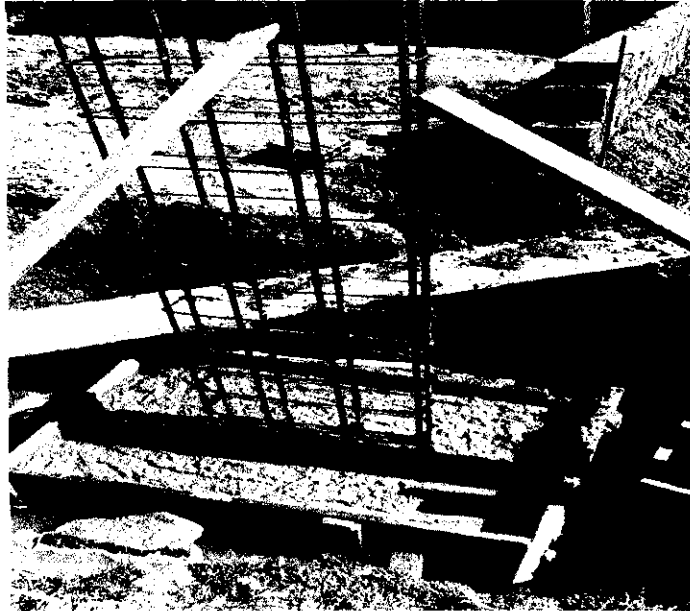
FOTO 68: Concretagem das sapatas
